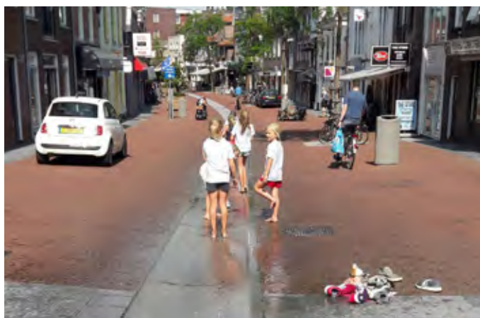
Bovengrondse waterafvoer. Referentie Woerden.
